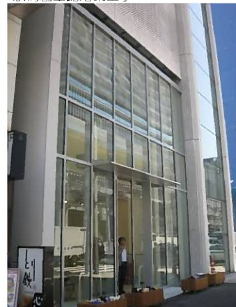
京橋創生館増築工事
