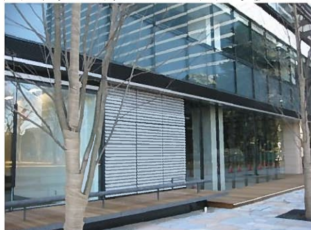
(仮称)中野四丁目開発計画区域4新築工事②
